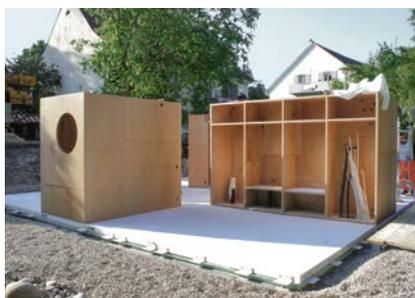
Nach Herstellung der Bodenplatte wurden die Holzkuben aufgestellt. Sie wirken wie Möbelstücke, tragen aber später die Betonstreifen, auf denen das Dach aufgebaut ist.
